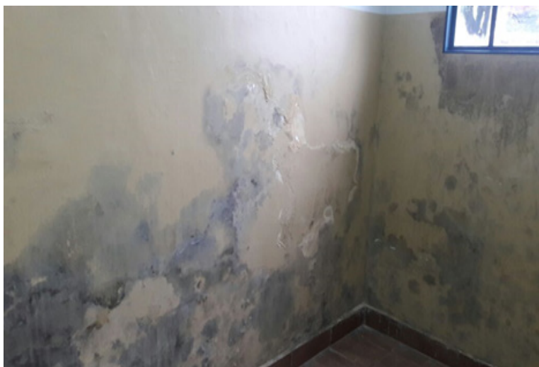
Figura 02 Cômodo que necessitava de reforma
