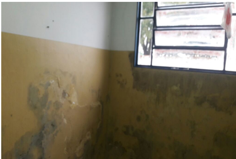
Figura 01 Cômodo que necessitava de reforma
