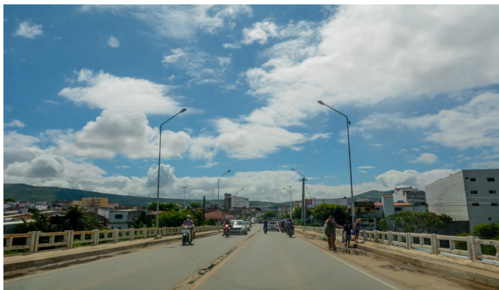
Figura 7 - Ponte sobre o Rio Capibaribe que marca o limite entre Toritama-PE e Caruaru-PE
