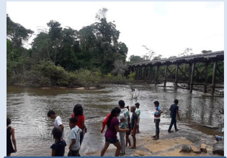
Ponte Rio Urubu
