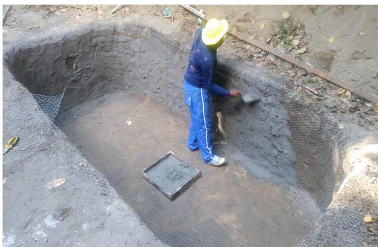
Figura 2: Revestimento com ferro-cimento.
