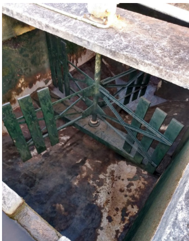
Figura 3 – Foto do floculador mecanizado de eixo vertical da ETA-TB.
