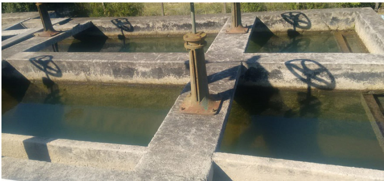
Figura 4 - Decantadores.
