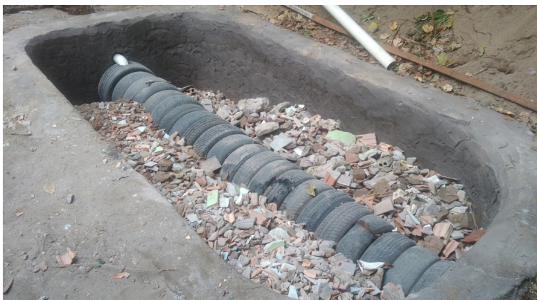
Figura 4: Colocação da camada de entulho de construção.
