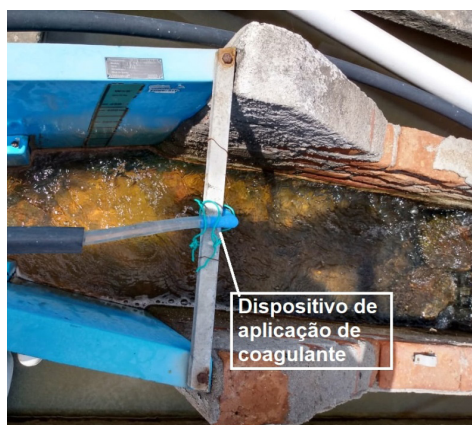
Figura 2 – Foto Ilustrativa da Etapa de Coagulação e Mistura Rápida em calha Parshall na ETA-TB.
