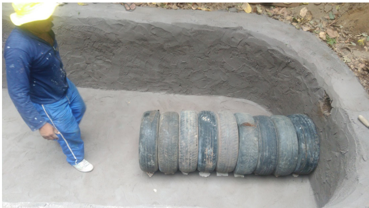
Figura 3: Empilhamento de pneus para câmara anaeróbica.
