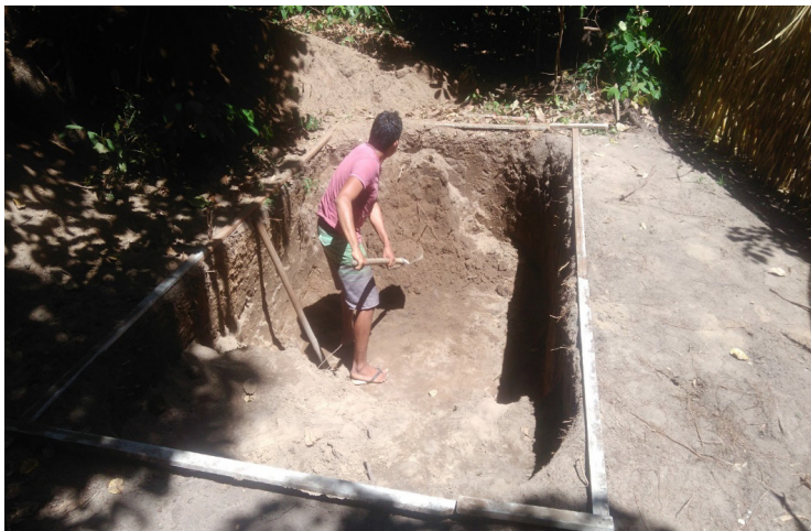
Figura 1: Escavação da trincheira para o TEvap.
