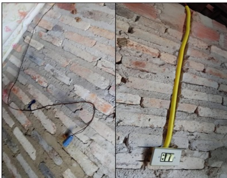
Figura 17: Antes e depois de instalação na qual foi adicionado o eletroduto com uma tomada e dois interruptores. Nessa residência em especial foram feitas instalações embutidas por já possuir os espaços necessários na parede.
