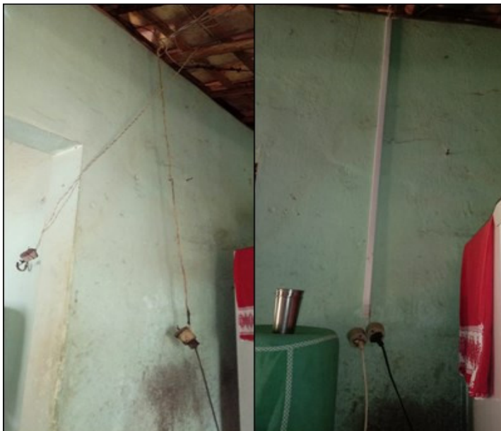
Figura 18: Antes e depois de instalação trocada, mostrando visivelmente uma melhora na estética e na segurança contra choques elétricos por contato direto.
