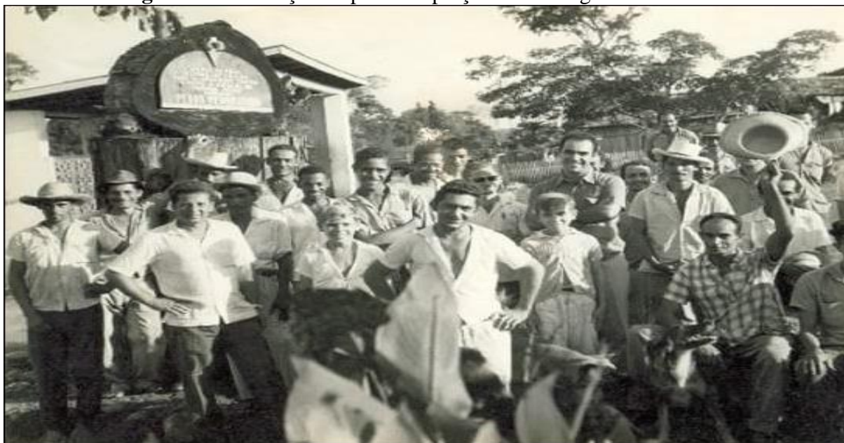
Figura 9 - Edificação da primeira praça central da gleba Rio Branco
