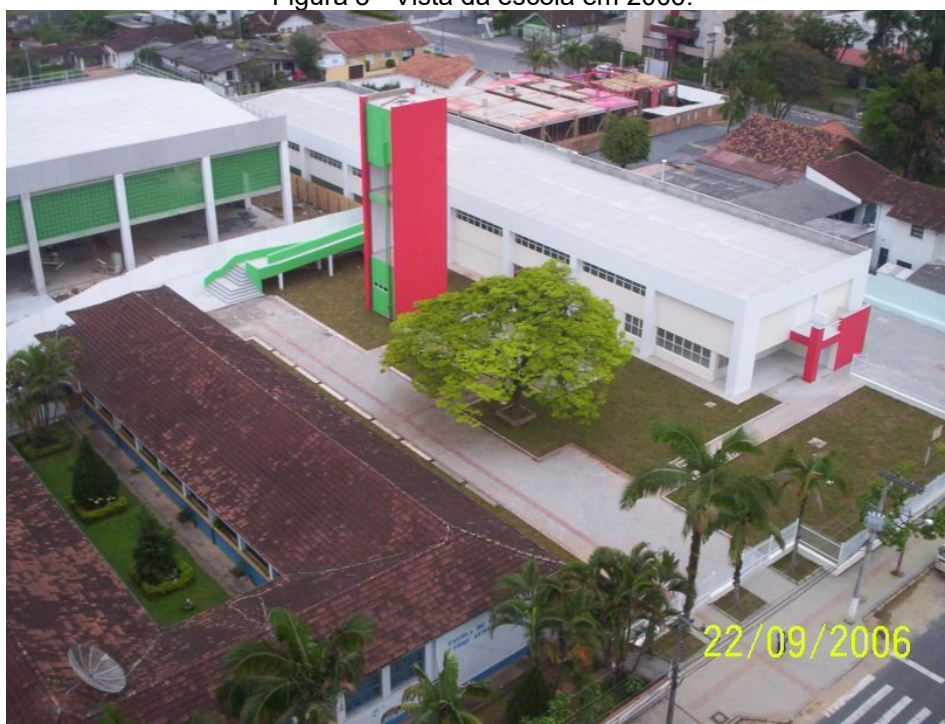
Figura 3 - Vista da escola em 2006.
