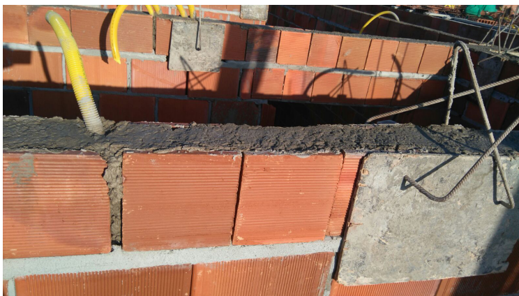
Figura 2. Cintas de amarração com bloco canaleta.
