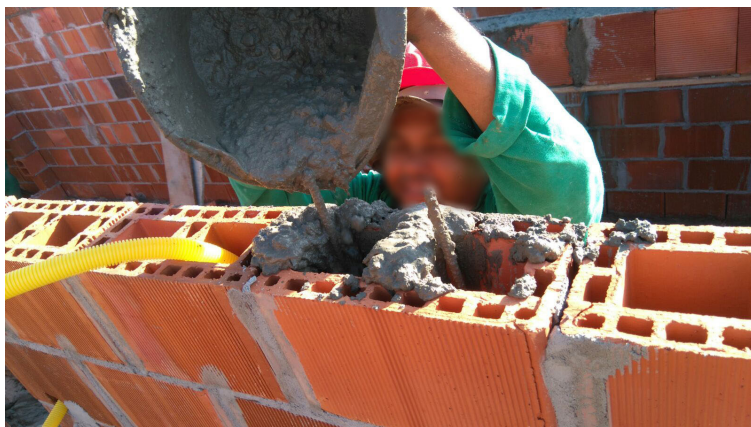
Figura 1. Preenchimento com graute.
