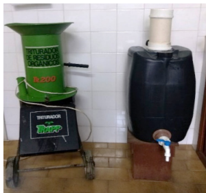
Figura 9 – Triturador de resíduos orgânicos (esquerda) e bombona utilizada como câmara de biodigestão (direita).
