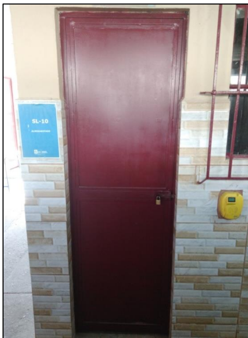
Figura 81: Porta de ferro do almoxarifado do Colégio Califórnia pintada após a utilização de zarcão. Fonte: Próprio autor.
