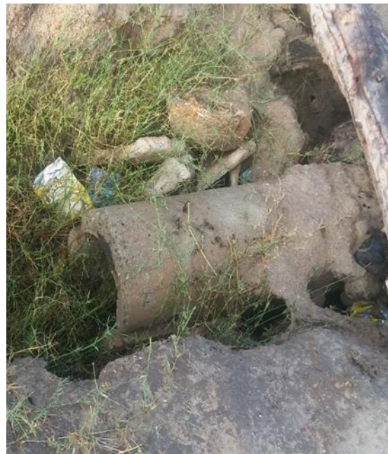
Figura 10. Tubulação de esgoto.
