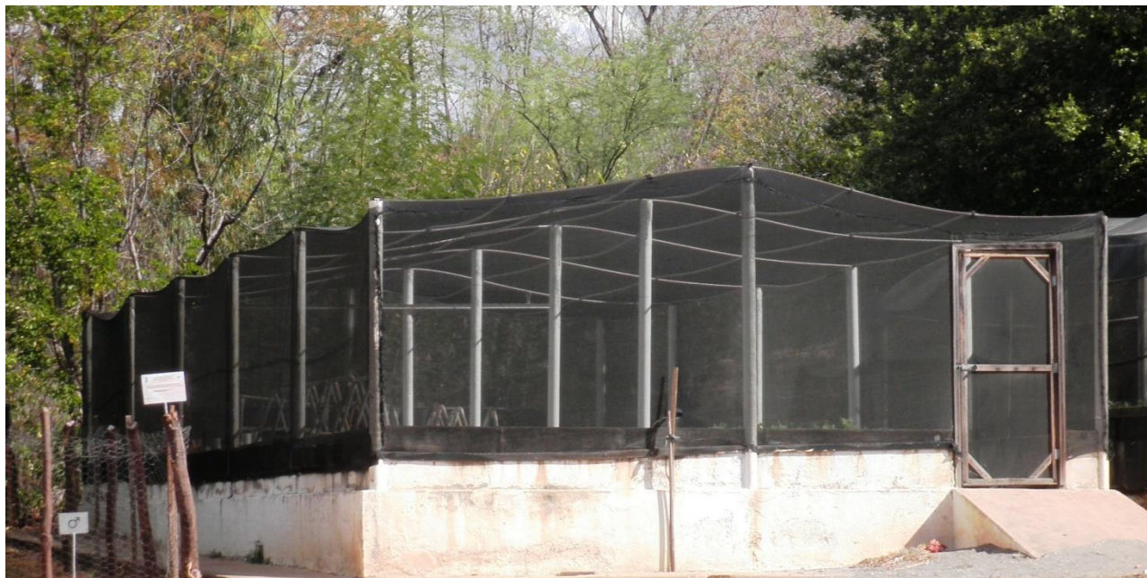
Figura 2. Casa de vegetação com ambiente telado (sombrite 50%) para a condução do experimento.
