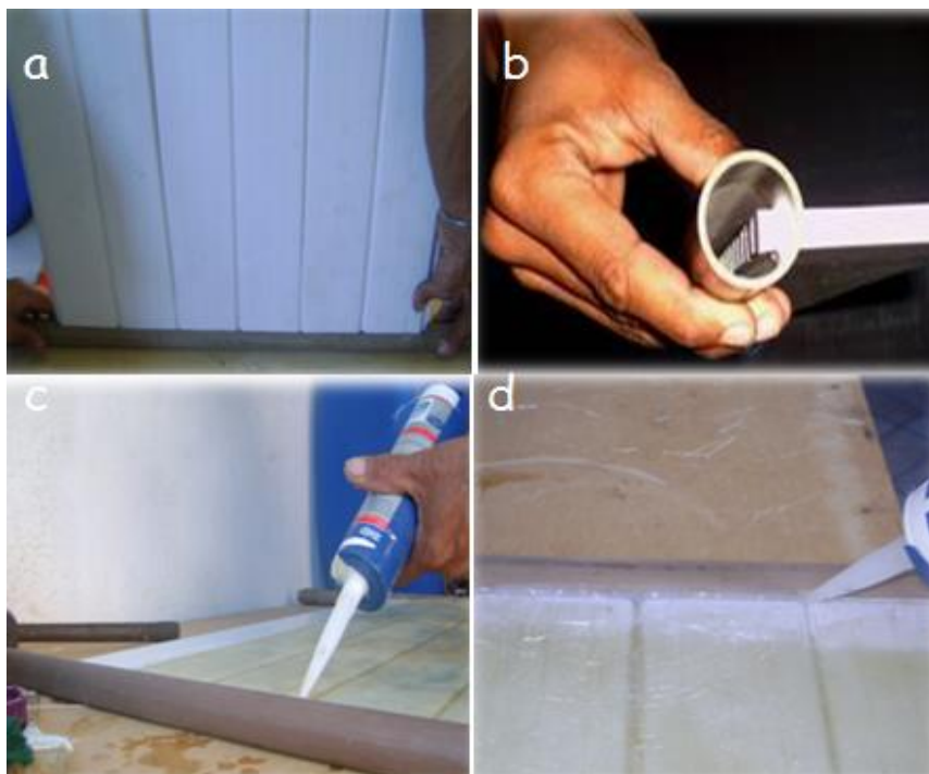
Figura 5. (a) Placa sendo encaixada no tubo; (b) Detalhe interno do tubo de PVC; (c) Colagem do forro no PVC; (d); Colagem das placas de PVC.
