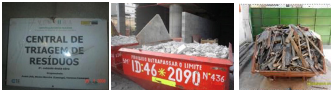
Figura 5- Triagem de resíduos durante a obra
