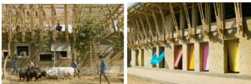
Figura 4 –A: METI School; B: Estrutura em V da cobertura de bambu e beiral da mesma;
