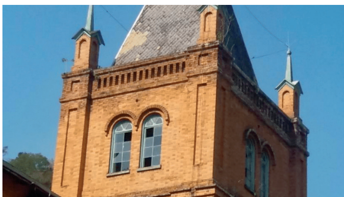
Foto 6 – Torre com vidros quebrados e telhado danificados
