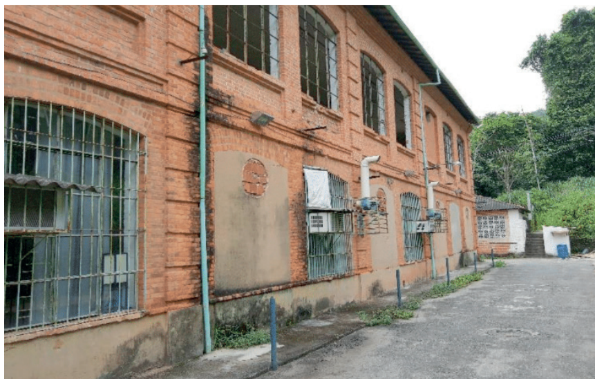
Foto 8 – Remoção de janelas e seu fechamento com tijolos.
