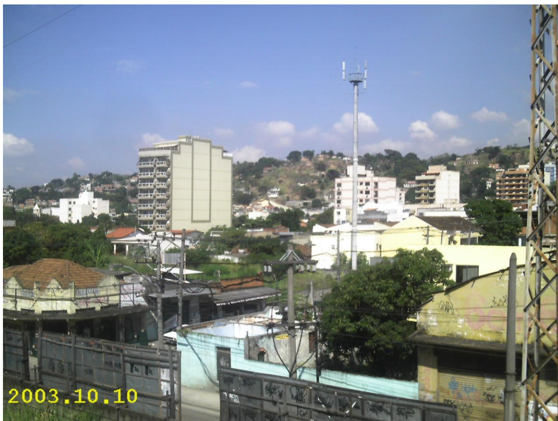
Fotografia 2: Vista do bairro k-11. Em 1ºplano observa-se o muro da EFCB (linha férrea). Ao fundo observam-se loteamentos e em destaque na paisagem alguns dos condomínios de luxo em questão. Data: Setembro /2006. Por: André Luís dos S. Oliveira.
