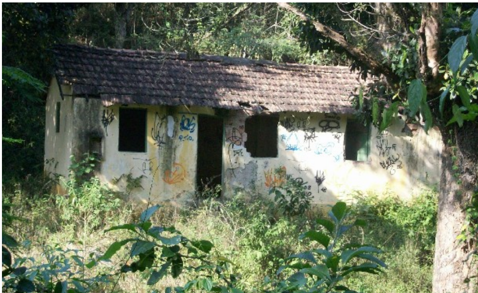
Fotografia 3: Residência desapropriada localizada nas proximidades da entrada da unidade de conservação. Data: Julho /2008. Foto: André Luís dos Santos Oliveira.
