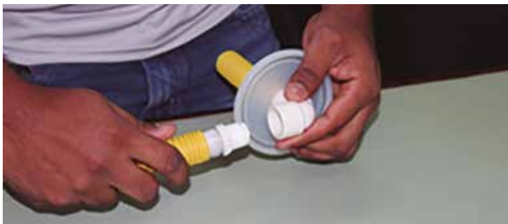
Figura 12 - Conexão da rosca fêmea em uma curva de 90°
