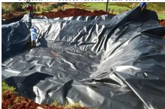
Figura 4 – Reservatório para esterco
