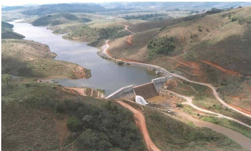
Figura 8- Usina hidrelétrica de Rosal
