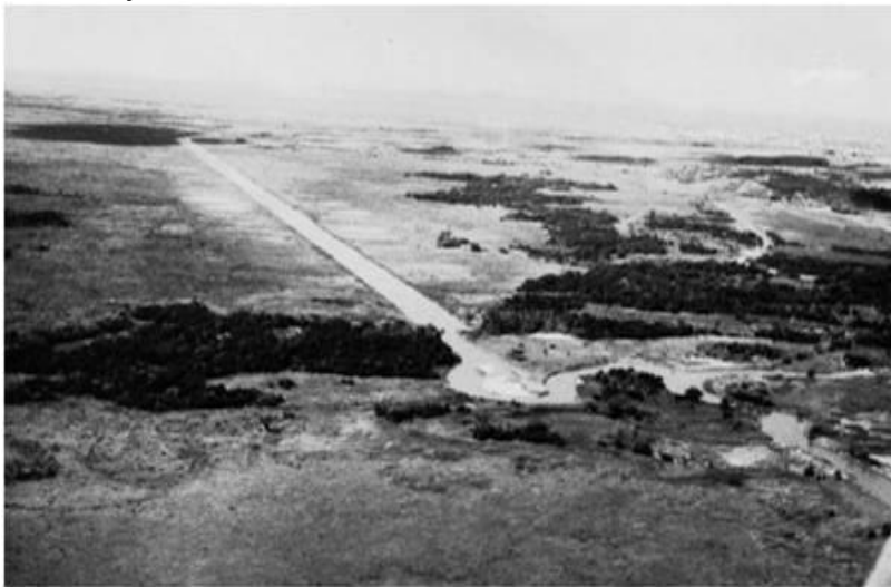
Figura 7- Registro da obra de retifica  o dos meandros do rio Itabapoana na altura do munic  pio de Gua  u   – ES em 1967.
