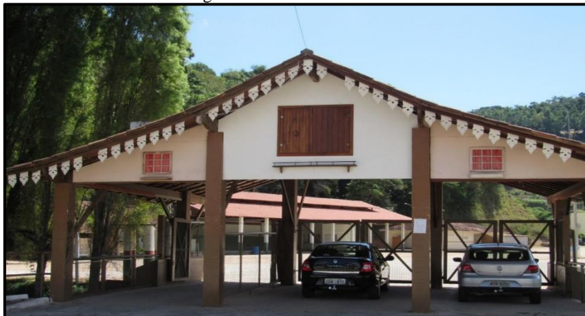
Figura 31- Centro de Eventos
