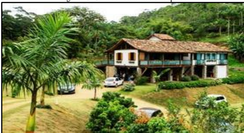
Figura 16- Casarão restaurado e adaptado
