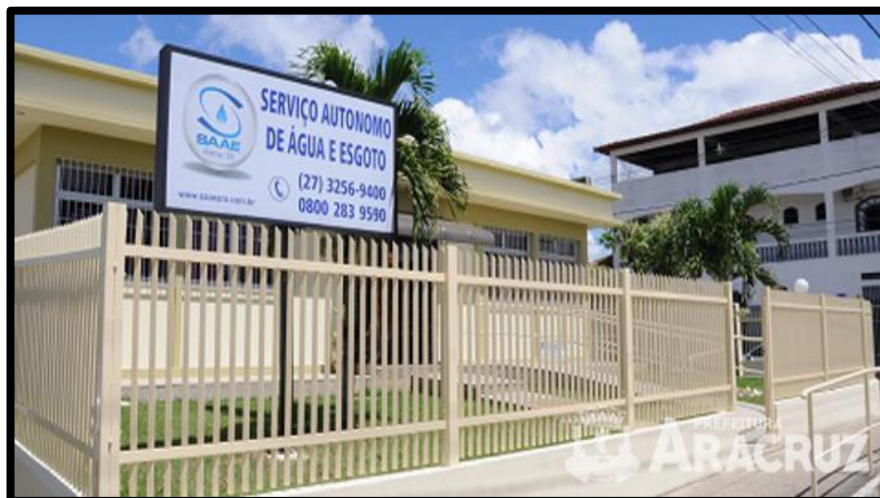
Figura 5: Prédio do Serviço Autônomo de Água e Esgoto (SAAE).
