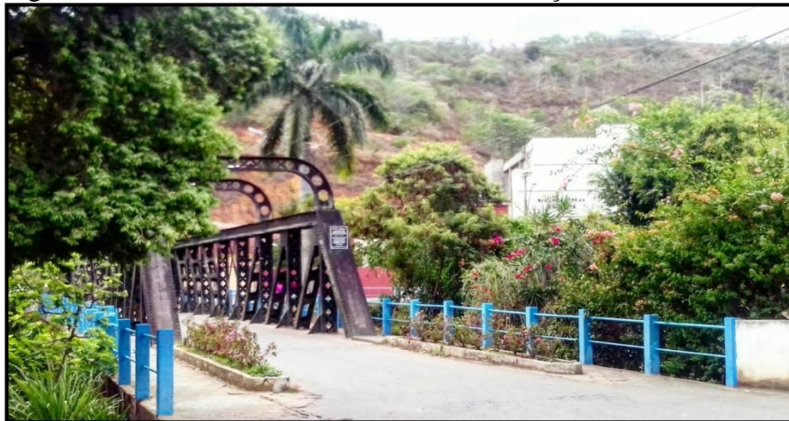
Figura 20 – Pontilhão de ferro da cidade de Guaçuí-ES.
