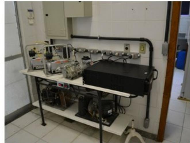
Parte elétrica dos equipamentos do laboratório de plastinação no lado externo da sala de desidratação e impregnação, como medida de segurança
