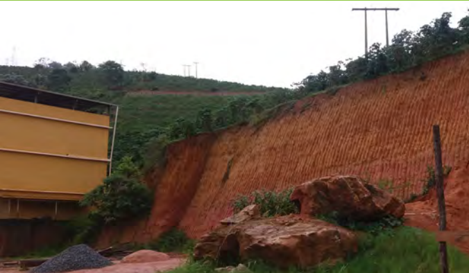
Foto 23: Encosta sendo removida para loteamento e construção de imóveis.
