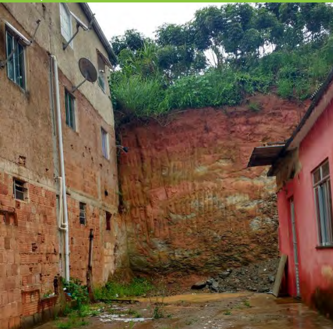
Foto 24: Residências construídas em áreas de risco com perigo de deslizamento de terra.
