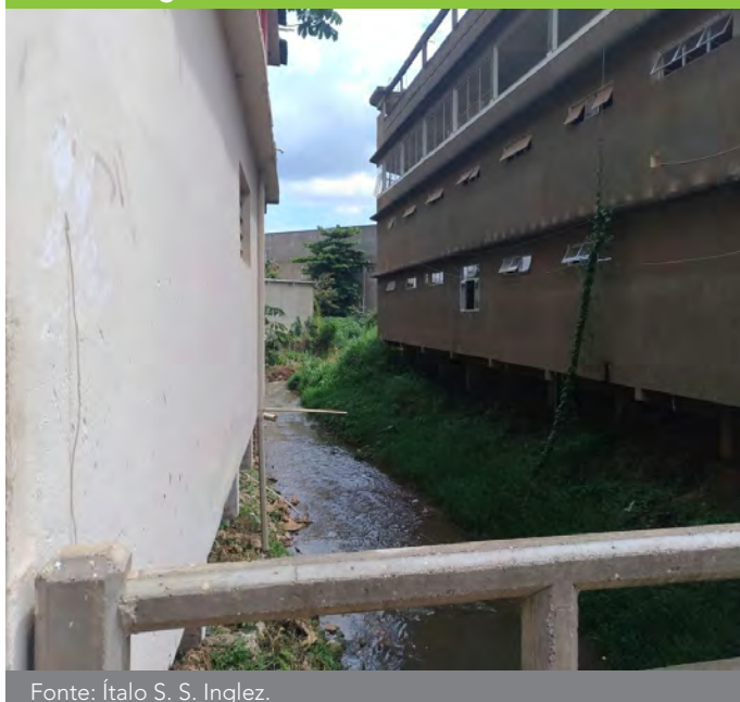
Foto 12: Trecho do rio Pardo no centro urbano de Ibatiba, com residências localizadas nas margens deste corpo hídrico lançando esgoto diretamente em suas águas.
