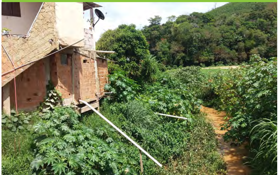
Foto 6: Casas construídas na margem do rio Pardo sem tratamento de esgoto, despejando os resíduos diretamente em suas águas.
