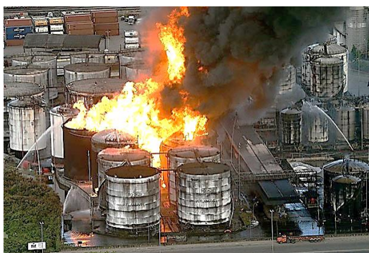
Figura 3 – Incêndios em tanques de combustível. Fonte: Retirado de http://odia.ig.com.br/
