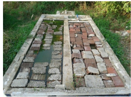
Figura 2: Biofiltros Submersos em situação operacional no período da pesquisa
