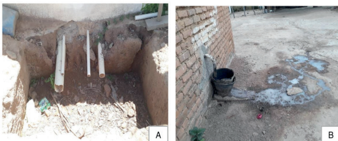
Figura 6 - Destino final dos efluentes na comunidade: A) fossa negra e B) à céu aberto;
