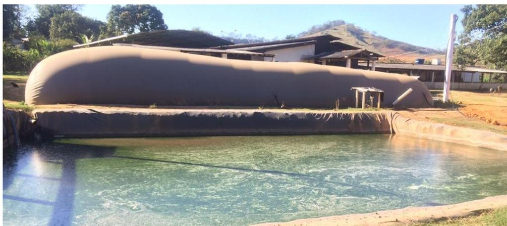
**Figura 2** - Biodigestor e lagoa de estabilização da ARS (Ifes-Campus de Alegre).
