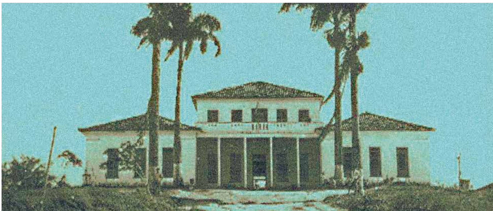
Figura 10 – Fachada do edifício-internato do Colégio Agrícola Benjamin Constant 1970.
