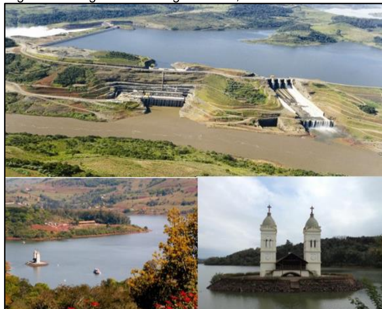
Figura 5 - Imagens da Barragem de Itá, Aratiba - RS
