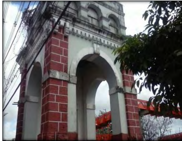
Imagem 02- Caixa d'água, Marituba- Pará
