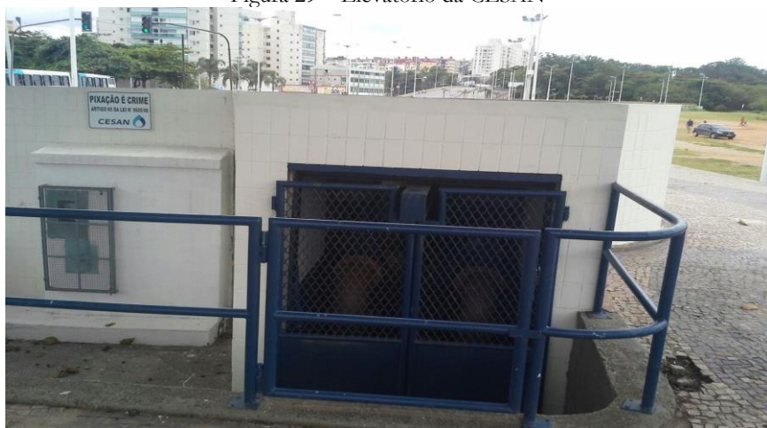
Figura 29 – Elevatório da CESAN
