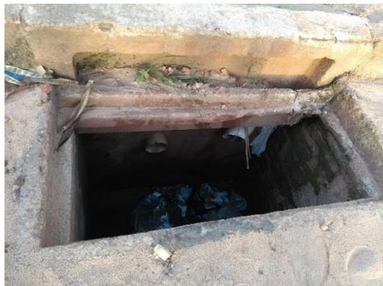
Figura 5: Boca de Lobo sem grelha e entupida de sedimentos (areia).
