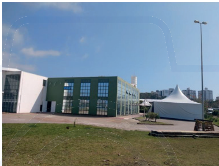
FOTOGRAFIA 35 – VISTA DO CÂMPUS FPOLIS-CONTINENTE
