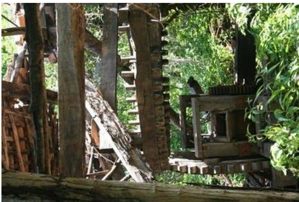
Ruínas de um engenho-de-pau de cana de açúcar, construído no século XIX. Sítio Fundão, Crato.
