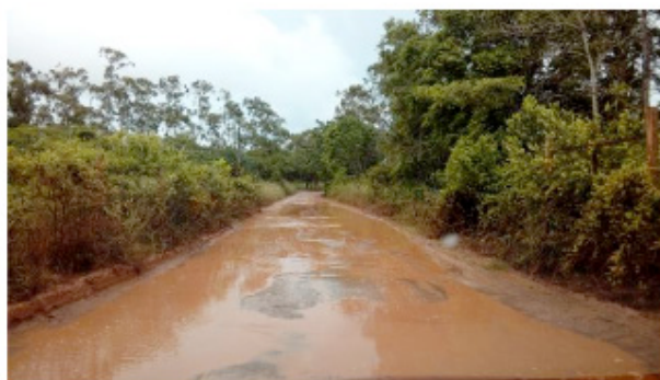
Imagem 3- Ramal de acesso à Escola
