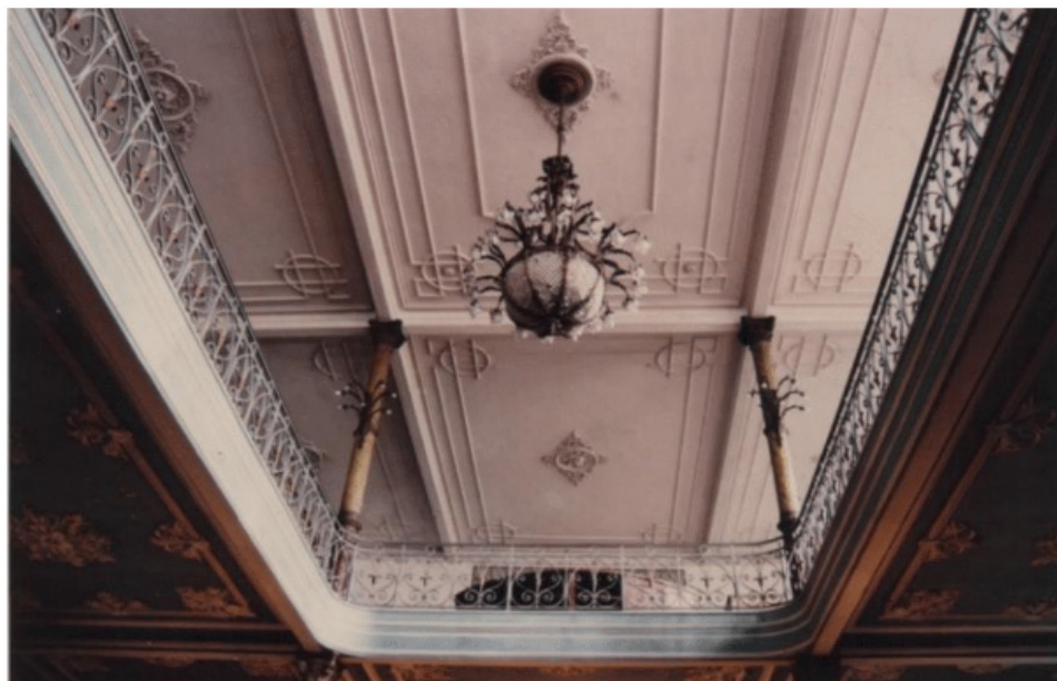
Foto 4: Estuques em gesso no forro.
