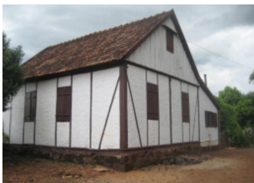
Figura 13 – Fachada da Residência Kreutz.
