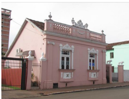
Figura 11 – Fachada da Casa Cemin.
