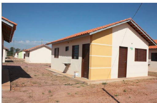
Figura 4 – Foto da edificação utilizada na avaliação de desempenho térmico
