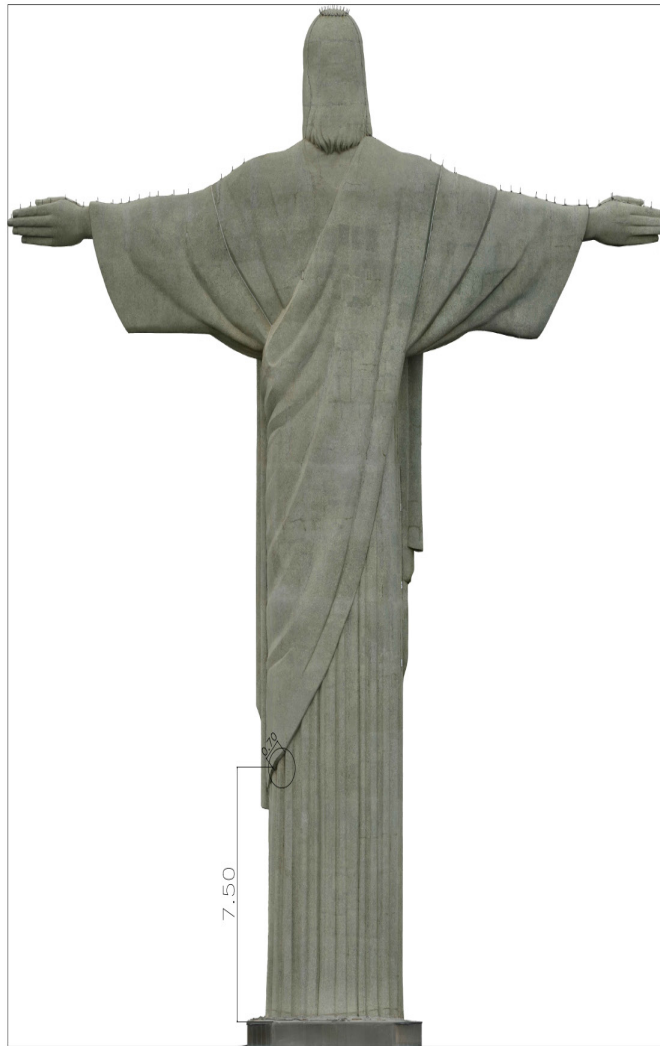
Figura 17: Fotogrametria com destaque para área do dano Fonte: Adolfo Ibañez , editado por Cristina Ventura..
