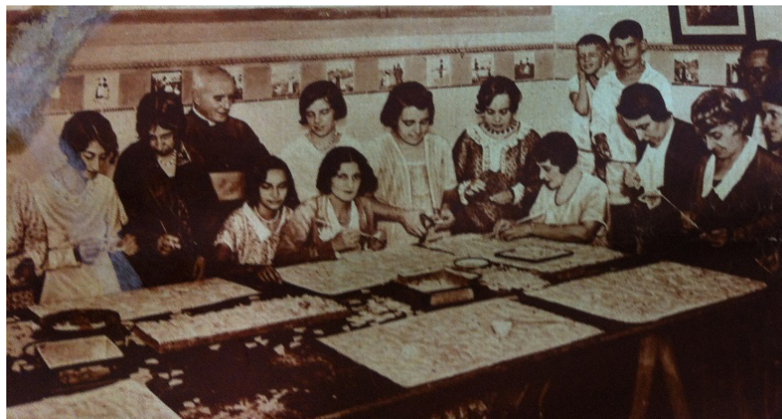
Figura 9: Montagem das placas de mosaico em pedra-sabão.
