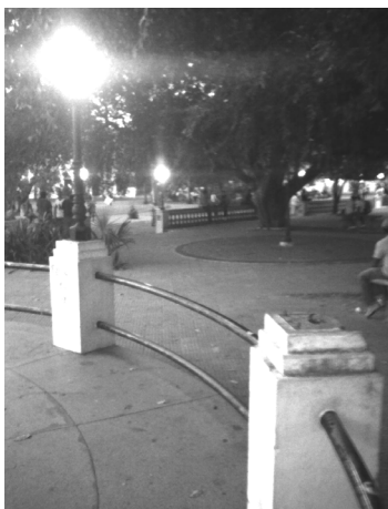
Figura 7: Detalhe do coreto da praça Pedro II. Depredação de um dos postes de iluminação. Destruição da memória.
