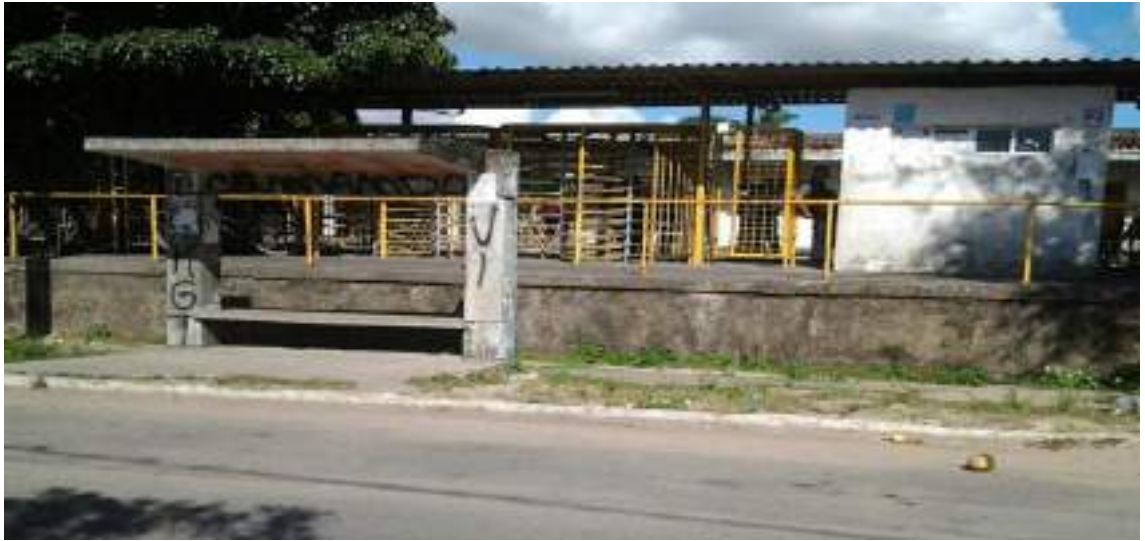
Foto 8: Estação do VLT em Pontezinha
