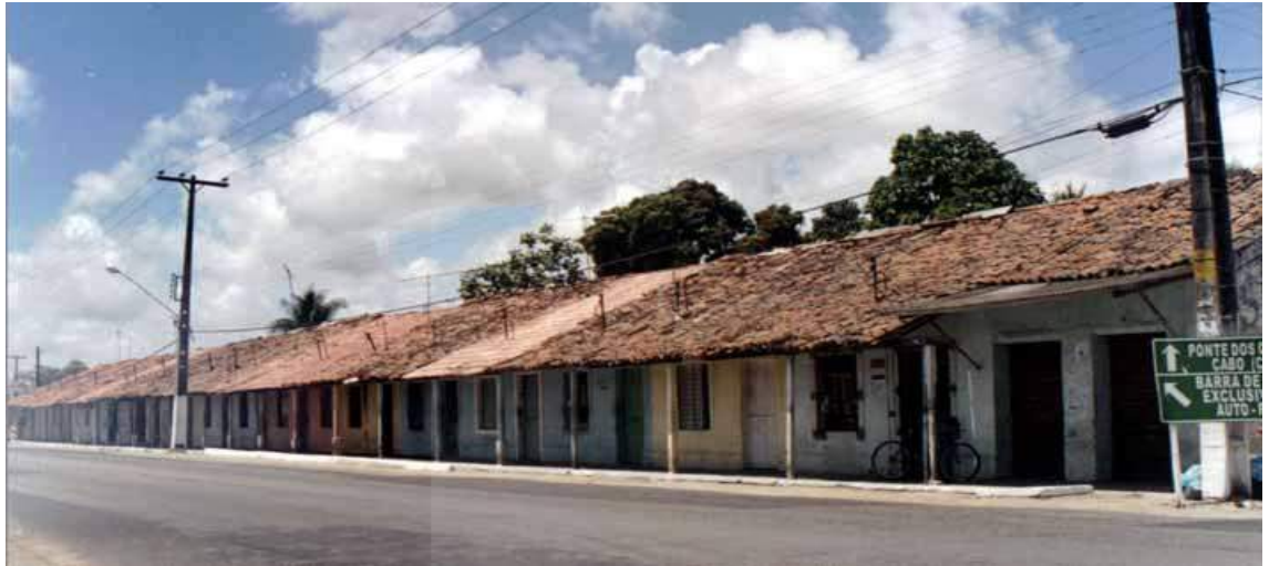
Foto 3: Imagem atual do casario de Pontezinha
