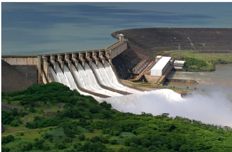
Figura 2.15 - Usina hidroelétrica de São Simão (GO). Fonte: http://www.brasil.gov.br/infraestrutura/2016/05/capacidade-instalada-de-geracao-de-energia-atinge-142-610-mw-em-marco/usina.jpg
