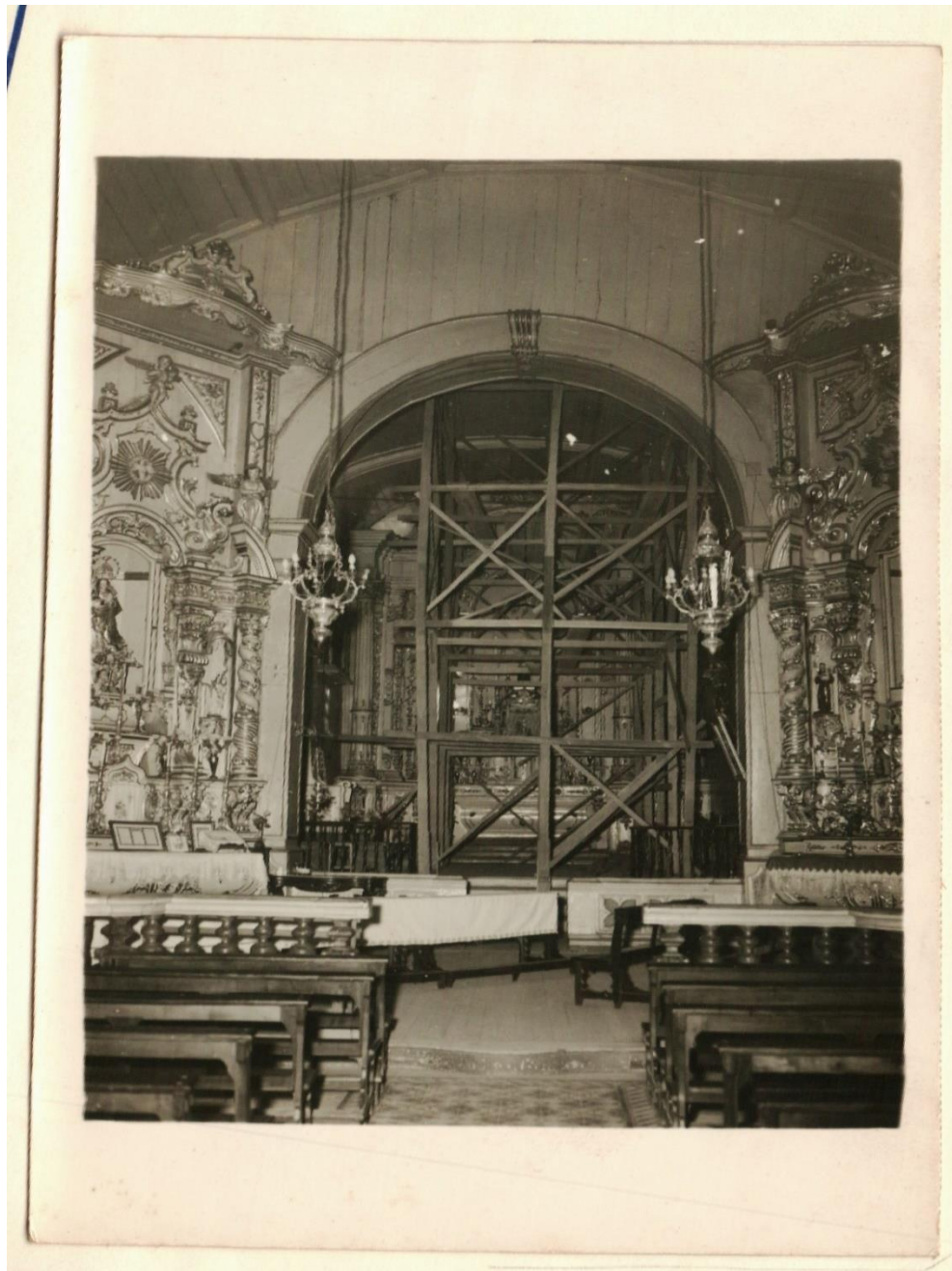
Fotografia em formato digital; mostrando o interior da Igreja Matriz do Senhor Bom Jesus de Cuiabá anterior à sua demolição. Em destaque na imagem estão presentes os altares gêmeos do cruzeiro da nave principal da igreja. À esquerda está o Altar do Cruzeiro esquerdo: dedicado a Nossa Senhora da Conceição; já a direita encontra-se o Altar do Cruzeiro direito: dedicado a Nossa Senhora de Sant'Ana. Na fotografia os altares já não possuíam mais sua cor original, por cima foi utilizada tinta de látex branca. No centro da fotografia, na capela-mor, a reforma pela qual tanto o retábulo-mor quanto a capela passaram. acervo pessoal cedido por Viviane Lozi Rodrigues.
