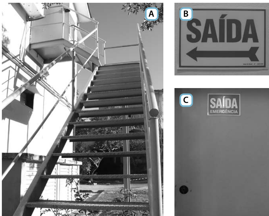
Figura 9 - (A) Escada de emergência, (B) sinalização da direção da saída mais próxima, (C) Porta de emergência.
