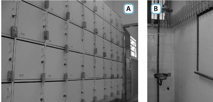
Figura 11 - (A) antecâmara com armários (B) chuveiro e lava-olhos de emergência.
