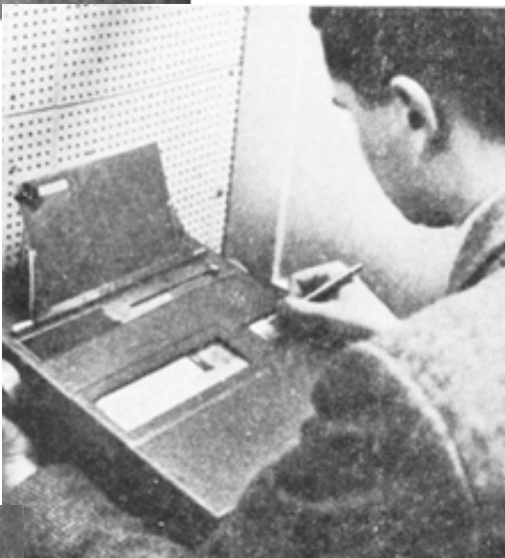
Figura 54: Máquina que corrige as respostas dadas pelo estudante para cada pergunta nela inscrita. (FONTE: acervo da UFRGS)
