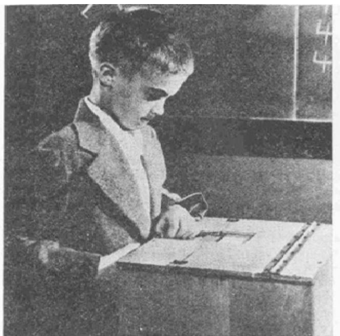
Figura 50: Máquina para o ensino de aritmética. Espaços são deixados em branco no material inscrito, no qual o estudante deve completar ao mexer em um cursor que apresenta as respostas. Com o cursor na posição escolhida, a máquina reconhece a resposta. Se correta, o estudante passa a responder outra questão. Se errada, o estudante não avança para a pergunta seguinte até que a responda corretamente. (FONTE: acervo da UFRGS)
