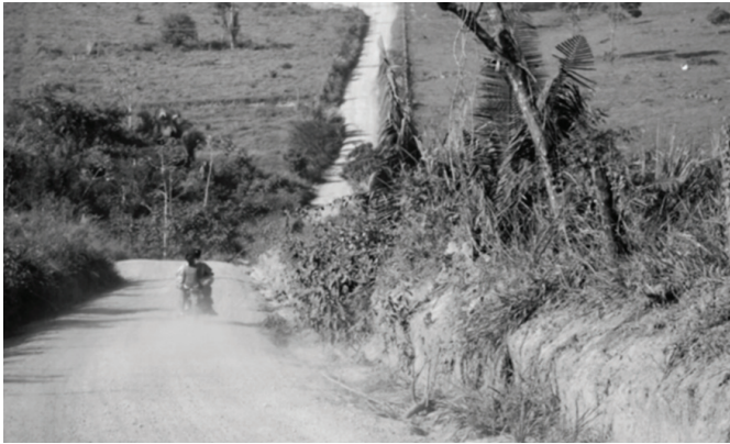
Foto: Estrada vicinal Portel/município de Pacajá- PA (julho/2012)
