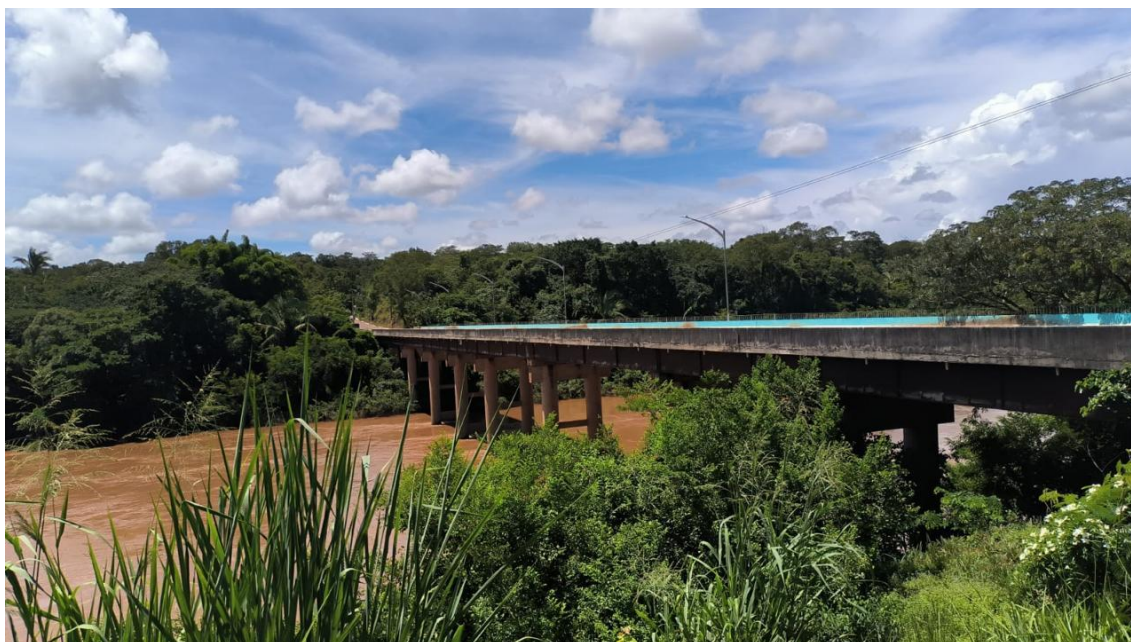
Imagem 3 – Ponte atual entre Torixoréu e Baliza Fonte: Juliana Pereira Costa 15/03/2025
