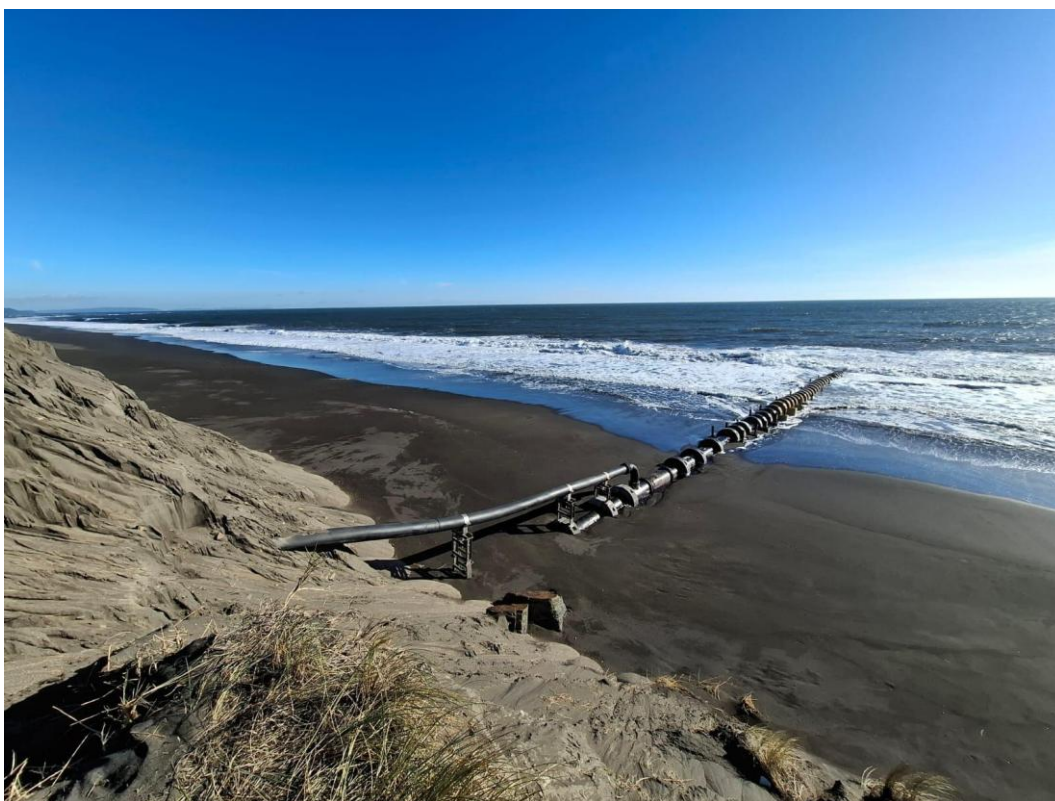
Figura 3. Trazado visible de la infraestructura del ducto y emisario submarino en la cuenca del Itata.
