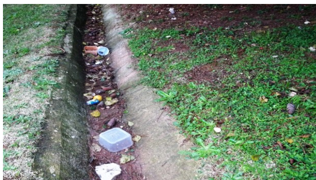
Figura 3 – Registro de descarte inadequado de resíduos no espaço escolar
