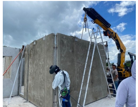
Figuras 8 e 9 – Grauteamento e Montagem
