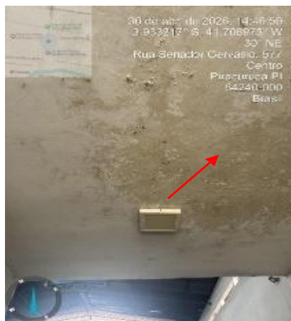
Figuras 20 e 21 – Infiltração na Laje.
