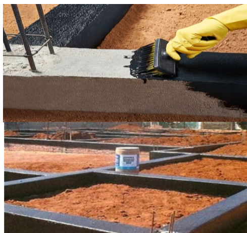
Figuras 09 e 10 - Aplicação de Emulsão Asfáltica em Viga Baldrame.
