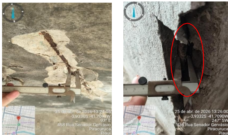
Figuras 18 – Paquimetria na Laje e 19 – Paquimetria no Pilar.
