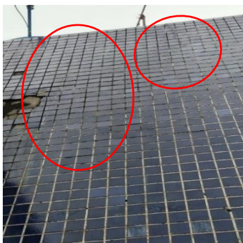
Figura 30 – Falha de rejuntamento e figura 31 – Registros de Deslocamento Cerâmico.
