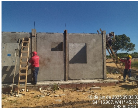
Figuras 8 e 9 – Grauteamento e Montagem
