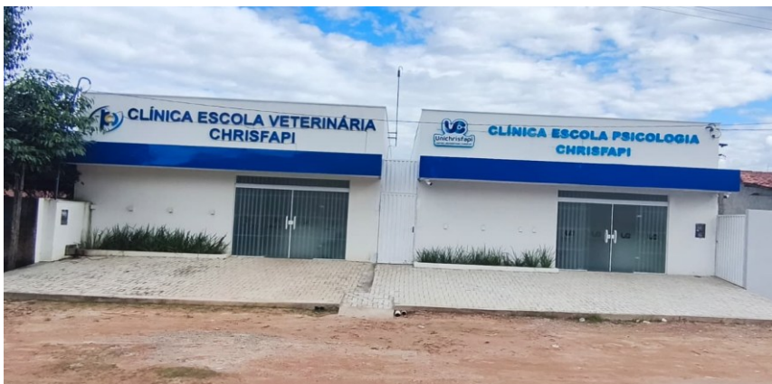
Figura 02 - Fachada frontal das edificações analisadas no Município de Piri-piri – PI.
