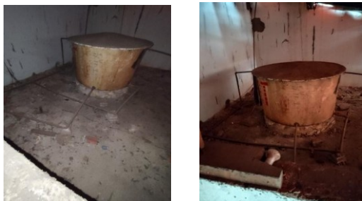
Figuras 34 e 35 – Imagens do Reservatório.
