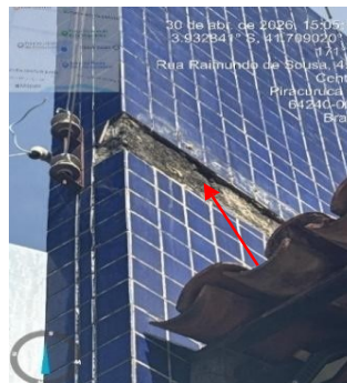
Figura 30 – Falha de rejuntamento e figura 31 – Registros de Deslocamento Cerâmico.
