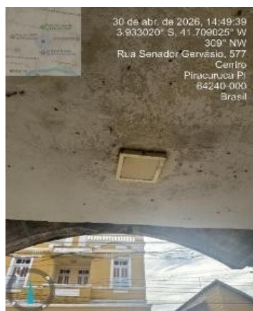
Figuras 20 e 21 – Infiltração na Laje.
