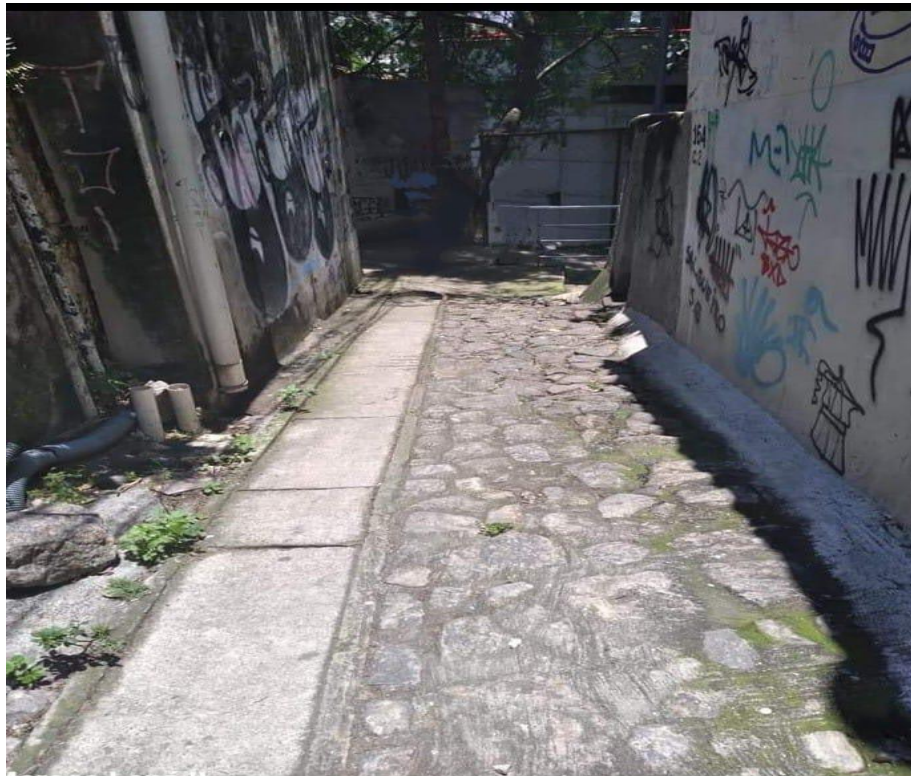
Figura 26 - Calçamento Pé de Moleque
